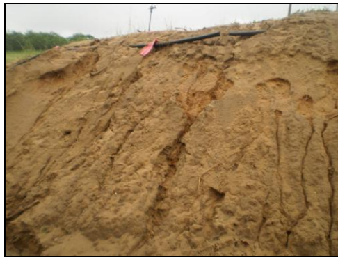
Imagen 26. Taludes presentes en la vía de acceso al sector de estudio – costado occidental de la Av. Circunvalar, donde se observa la presencia de niveles de areniscas friables afectadas por erosión en surcos
